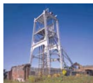
三池炭鉱宮原坑施設
