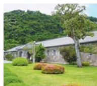
旧集成館機械工場
